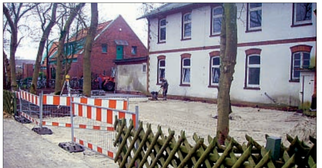
An der Schlossstraße entstehen Parkplätze mit einer eigenen Zufahrt.
