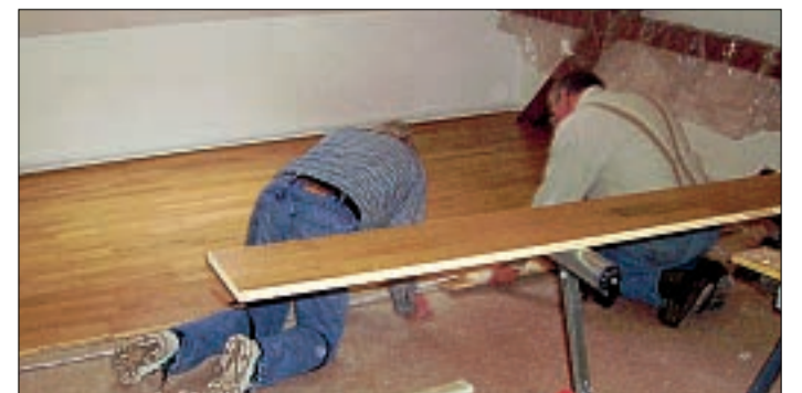
Insgesamt werden 570 Quadratmeter Parkett verlegt.
